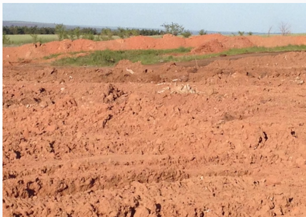
Свалка ТБО после выполнения работ
