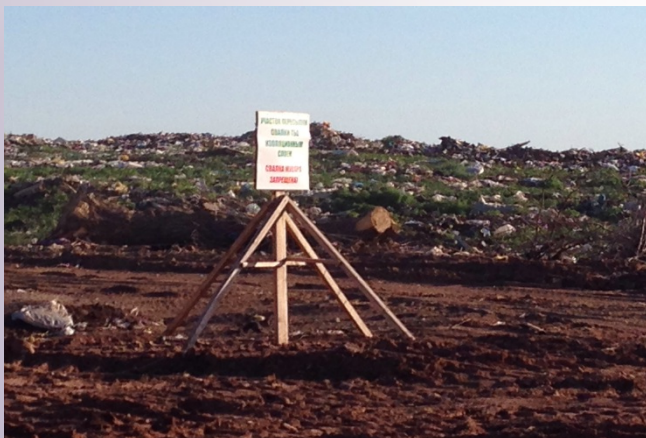
Свалка ТБО до начало работ по пересыпке ОМС
